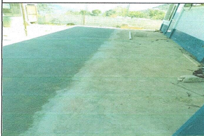
Foto 4: Avance del corredor donde se colocará torta de cemento.
