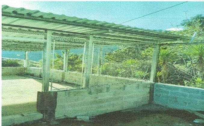
Foto 1: Avance en aula donde se cambia las láminas que estan en mal estado y mal aseguradas.
